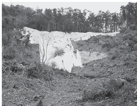
慰霊碑の後の山に土砂崩れが起こり、半月経ってもビニールシートがかけてあるだけで復旧は進んでいなかった（8月24日、烏来）
